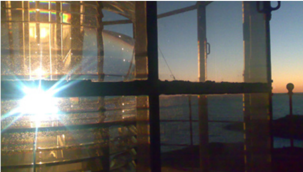
I 15 sekunder tändes lilla 40-watts lampen om och om igen innanför det megastora glasprismat.
